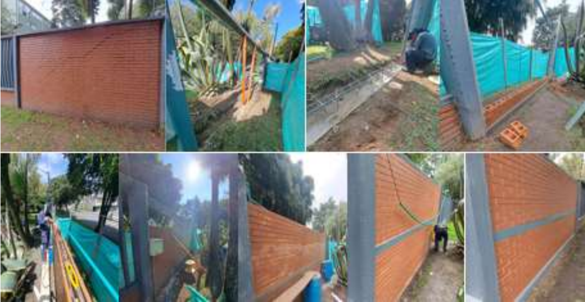
Imagen 35. Reconstrucción de muro de cerramiento zona C, sobre la calle 59
