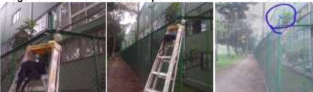
Imagen 31. Cambio de fotocelda por daño
