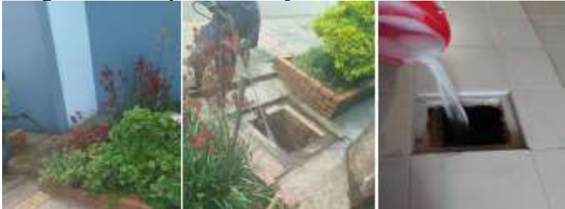
Imagen 33. Limpieza de cajas residuales
