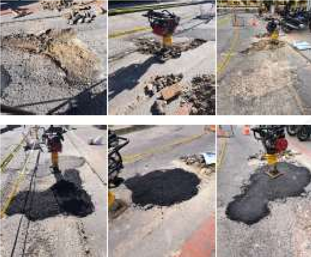
Imagen 27. Taponamiento de huecos con asfalto frio en vías internas
