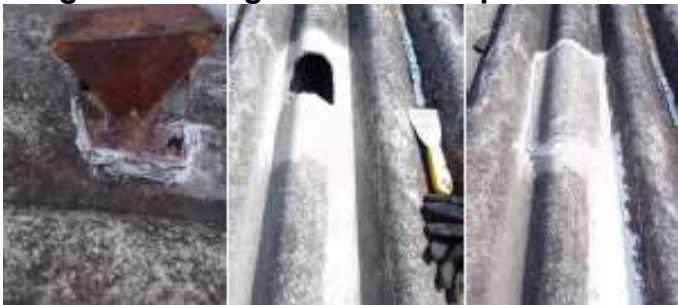
Imagen 24. Arreglo de cubierta por filtración de agua
