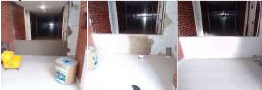
Imagen 22. Instalación de muro de antepecho
