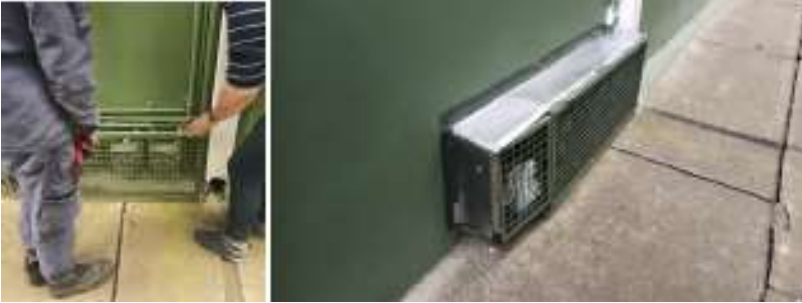
Imagen 9. Instalación de flanche en la caja de gas por filtración de agua
