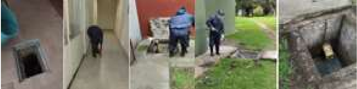
Imagen 16. Limpieza y mantenimiento de las cajas de aguas negras de los bloques
