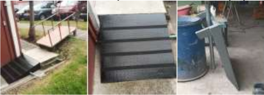
Imagen 12. Terminación para instalación de rampa por daño existente
