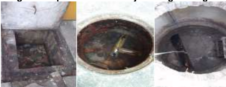
Imagen 7. Taponamiento de cajas de aguas negras de Bloque
