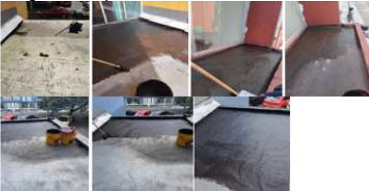
Imagen 26. Impermeabilización de cachuchas
