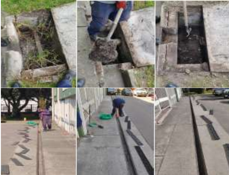
Imagen 6. Limpieza de sumideros y rejillas de todos los bloques del conjunto
