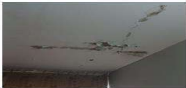
VISITA A APARTAMENTO 103 BLOQUE D21 POR FILTRACION D AGUA PROVENIENTE DEL APARTAMENTO 406 DEL MISMO BLOQUE
