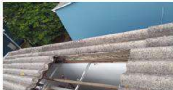
CAMBIO DE CUBIERTA POR TEJA ROTA BLOQUE A16 APTO 401 INTERNAMENTE DENTRO DEL APARTAMENTO QUITARON UN PEDASO DEL CIELO RASO
