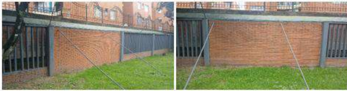
ACARREO DE MATERIAL DE OBRA PARA ARREGLO Y ADECUACION DE PARABOLICA PARA TRABAJOS DEL PERSONAL
