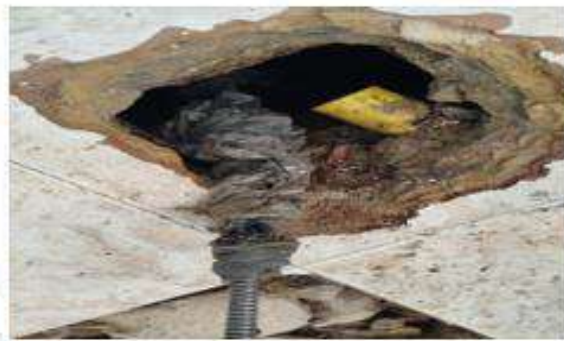
DESTAPONAMIENTO DE CAJA DE AGUAS RESIDUALES EN EL CUARTO DE ASEO EN EL BLOQUE B1-B2
