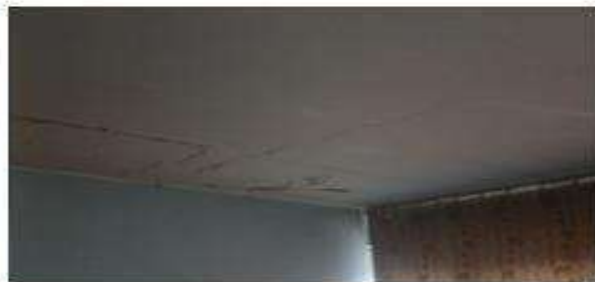
VISITA A APARTAMENTO 103 BLOQUE D21 POR FILTRACION D AGUA PROVENIENTE DEL APARTAMENTO 406 DEL MISMO BLOQUE
