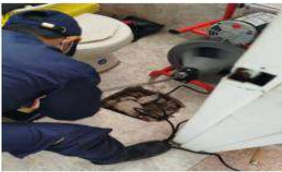
DESTAPONAMIENTO DE CAJA DE AGUAS RESIDUALES EN EL CUARTO DE ASEO EN EL BLOQUE B1-B2
