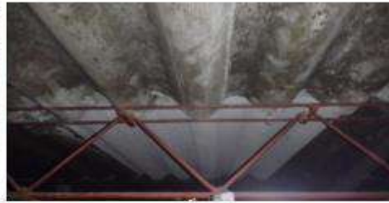
CAMBIO DE CUBIERTA POR TEJA ROTA BLOQUE A16 APTO 401 INTERNAMENTE DENTRO DEL APARTAMENTO QUITARON UN PEDASO DEL CIELO RASO
