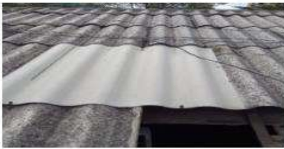
CAMBIO DE CUBIERTA POR TEJA ROTA BLOQUE A16 APTO 401 INTERNAMENTE DENTRO DEL APARTAMENTO QUITARON UN PEDASO DEL CIELO RASO
