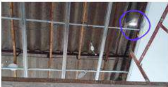
CAMBIO DE CUBIERTA POR TEJA ROTA BLOQUE A16 APTO 401 INTERNAMENTE DENTRO DEL APARTAMENTO QUITARON UN PEDASO DEL CIELO RASO
